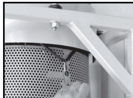
Étape 3 Enlever l'ancien joint.
